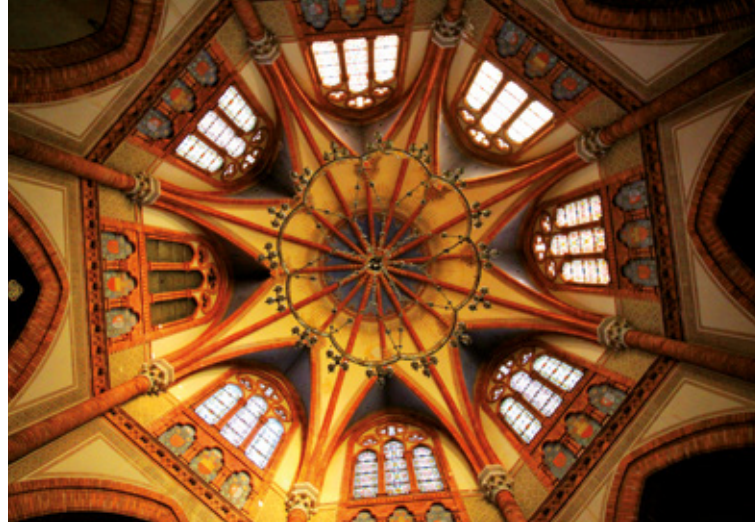
Kopule novogotického kostela v Poštorné. V exteriéru i interiéru stavby byly využity materiály z knížecí keramičky. Foto David Mahovský
